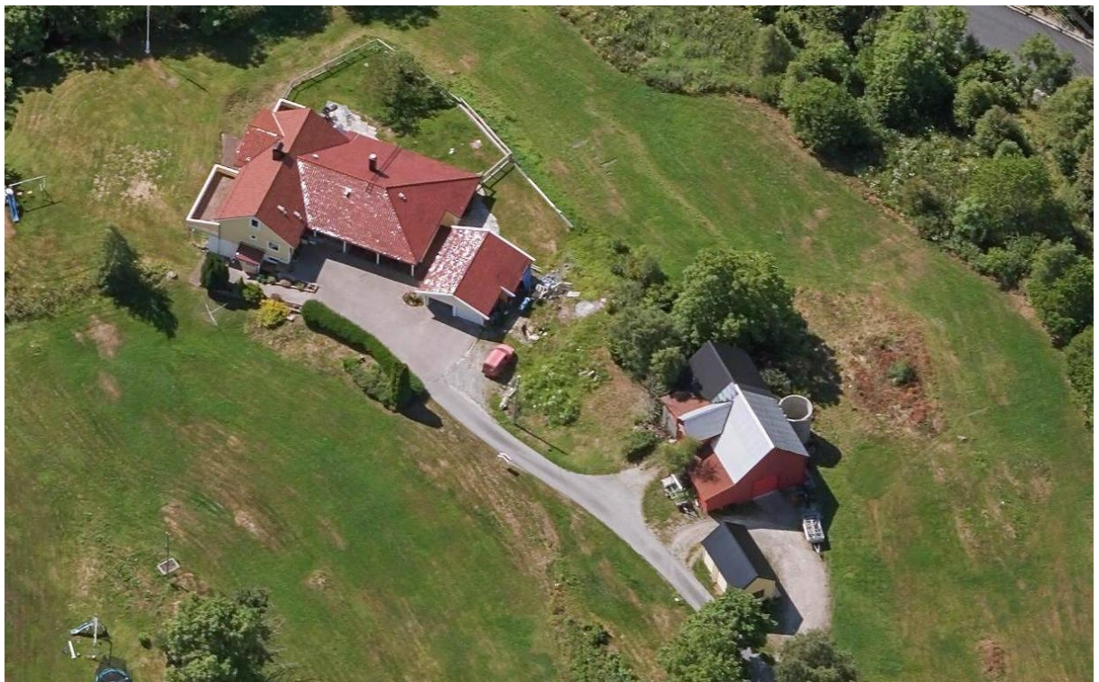
Figur 2: Skråfoto som viser bygningane innanfor planområdet (kart.1881.no)
