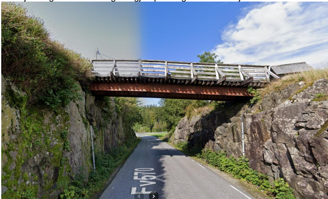
Figur 6: Bru over Fensfjordvegen (google maps)
