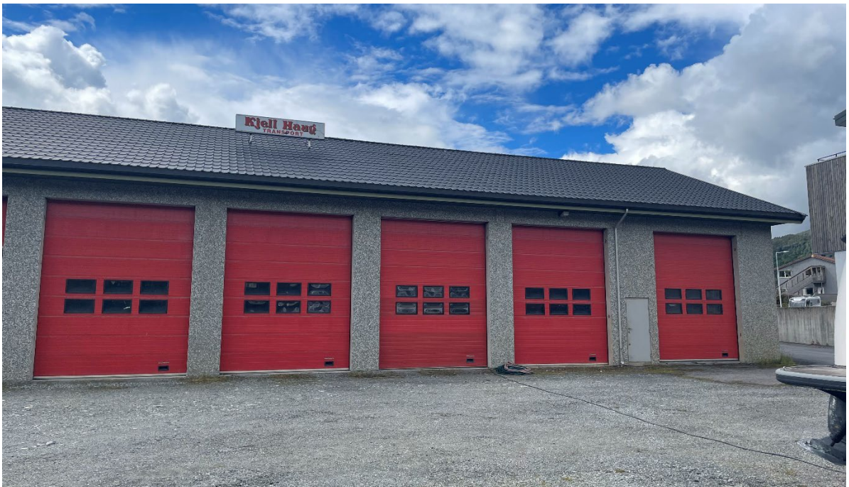
Figur 3. Fasade mot nordaust.
