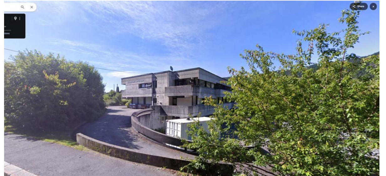
Et bygg brukt til offentlig tjenesete
