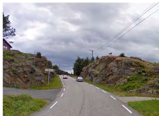
Fylkesveg 151 mot Stolmasundet bru
